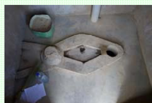
Intérieur de la latrine
