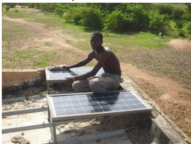
Nettoyage plaques solaires
