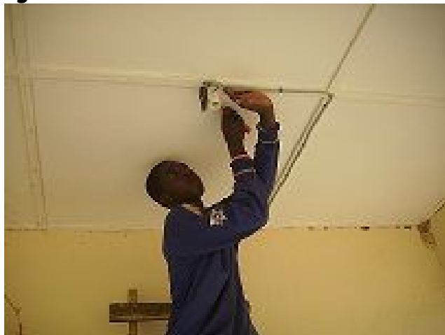
Fixation de la douille de lampe
