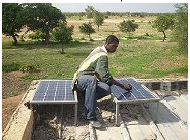
Nettoyage de plaques solaires
