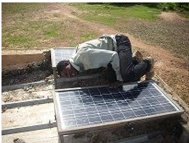
Contrôle du branchement
