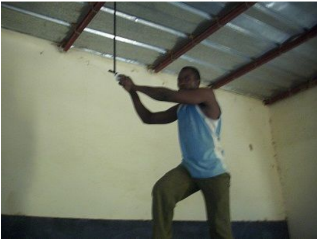
Fixation des supports de lampe
