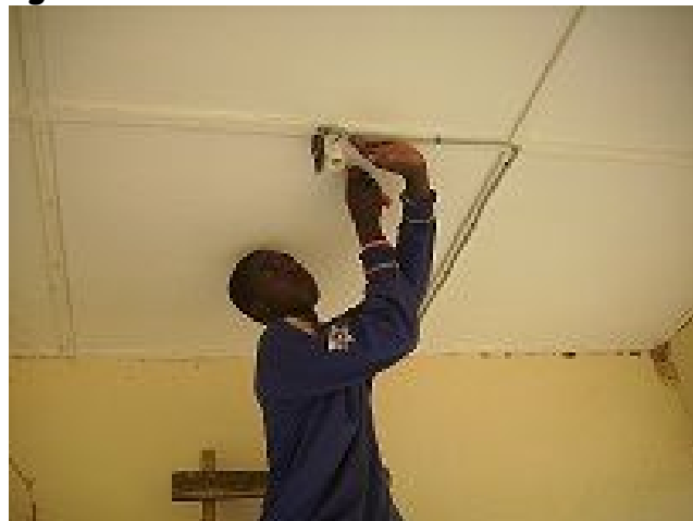
Fixation de la douille de lampe
