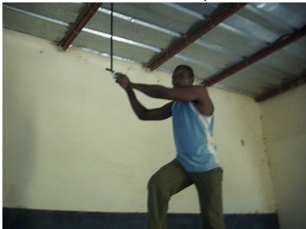
Fixation des supports de lampe
