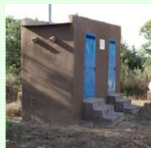
Bloc de 2 latrines
