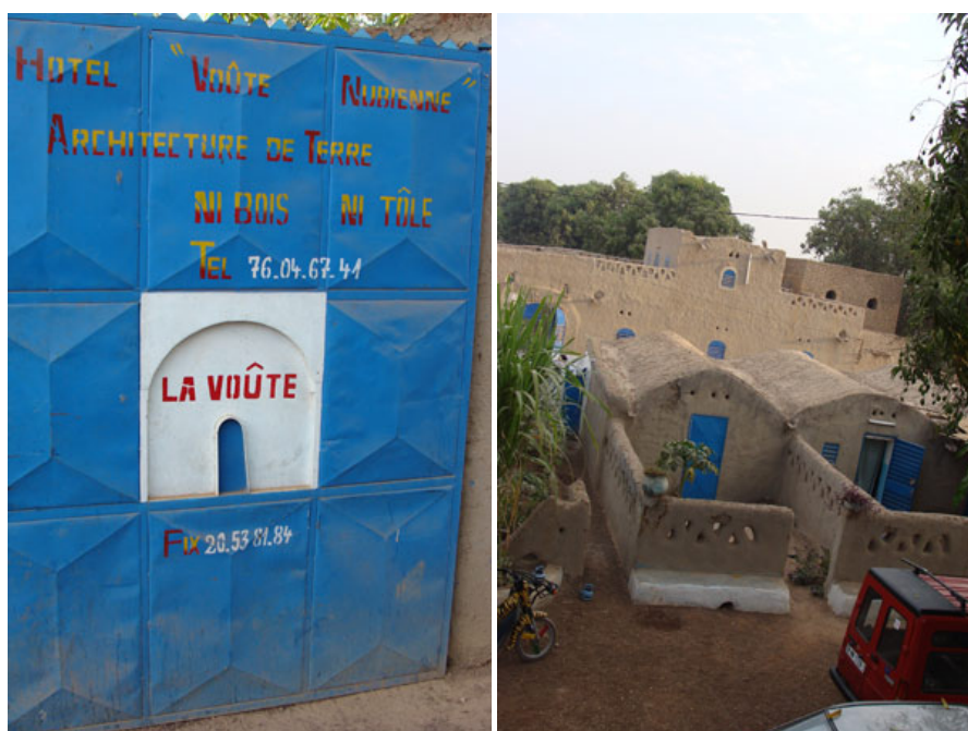
Portail d'entrée de l'hôtel des voûtes – vue sur deux chambres
